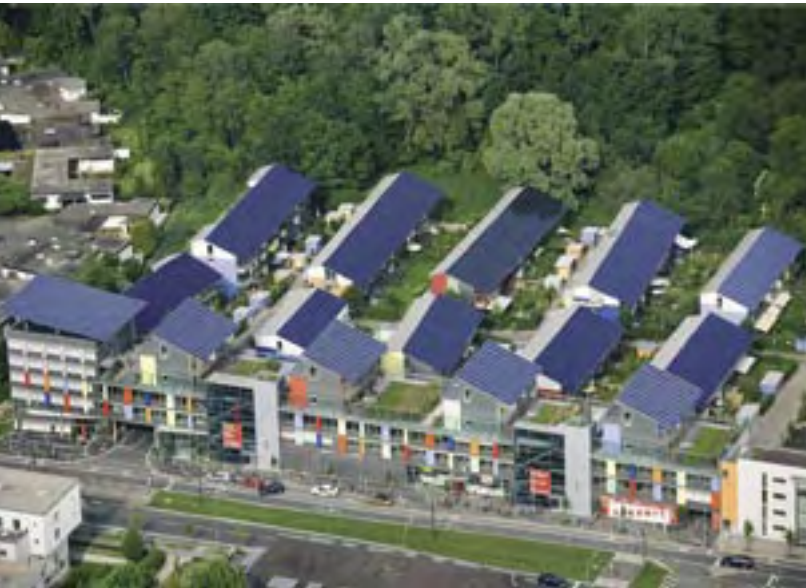
Solarsiedlung am Schlierberg in Freiburg im Breisgau.
