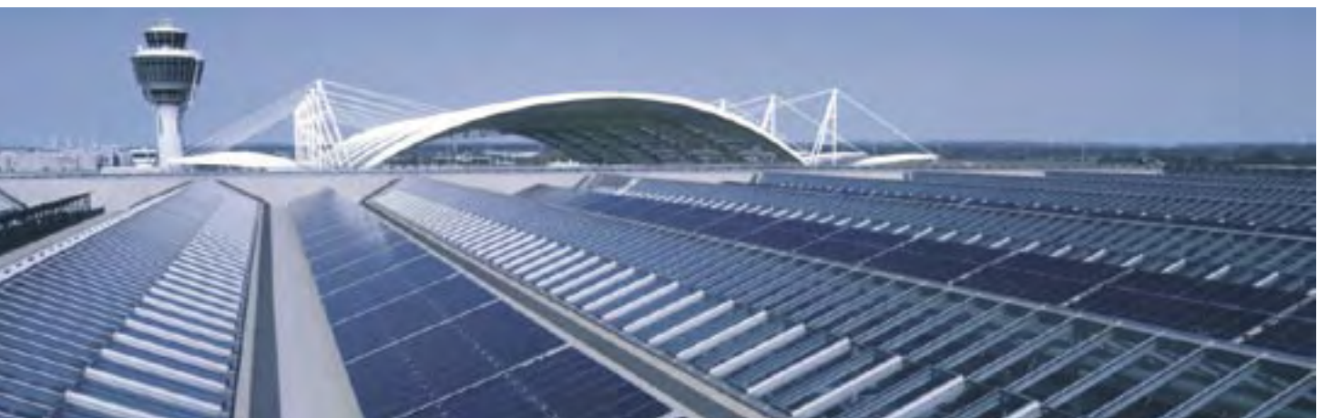
Der Flughafen München nutzt Photovoltaik, um seinen Energiehaushalt zu entlasten.
